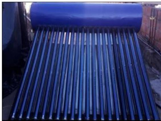
**Figura 4.** Calentador solar de tubos al vacío
