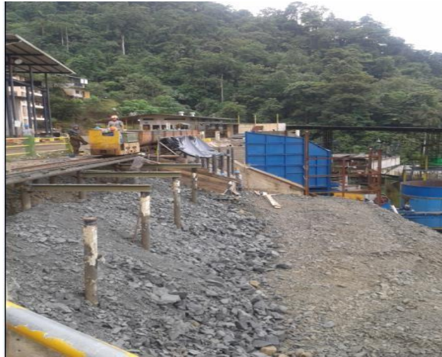
Figura 3: Transporte del Material con Locomotoras a Baterías
