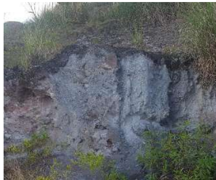
Figura 22. Corte en sección de un suelo arenoso.
