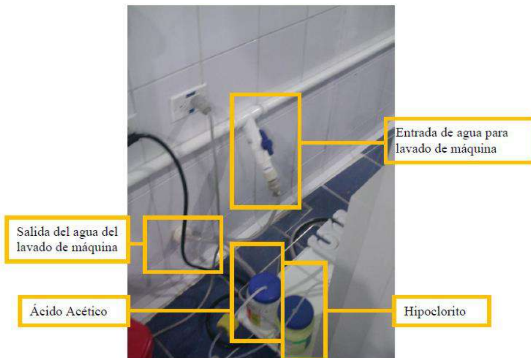
Figura 2. Proceso de limpieza de máquinas de hemodiálisis.
